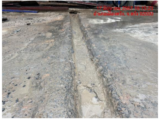
รูปที่ 3.1-47 รางระบายน้ำรอบพื้นที่ก่อสร้างโครงการ
