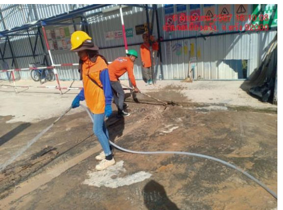
รูปที่ 3.1-23 การขุดลอกตะกอนที่สะสมในรางระบายน้ำ
