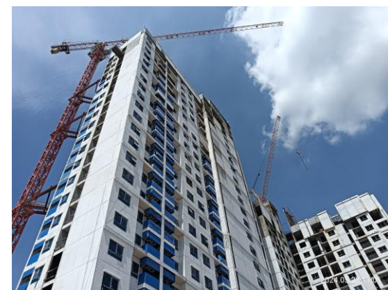
รูปที่ 3.1-80 ควบคุมกวาดแนของเครนให้อยู่ภายในพื้นที่ โครงการ
