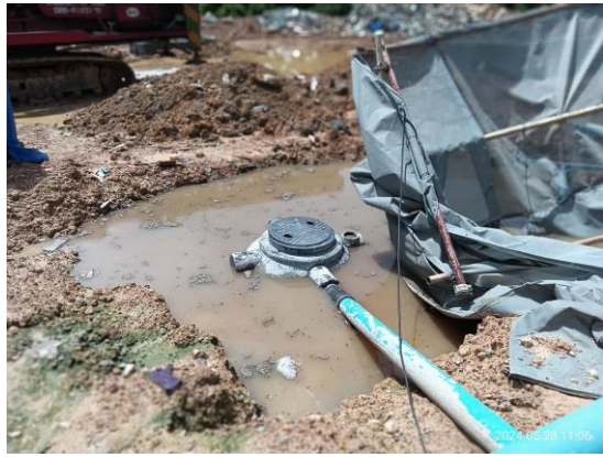
รูปที่ 3.1-28 ถังบำบัดน้ำเสียสำเร็จรูปในพื้นที่โครงการ
