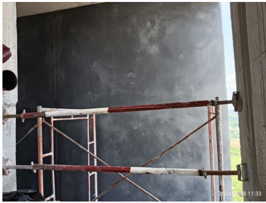
รูปที่ 3.1-70 ราวกันตกหรือตาข่ายนิรภัย สำหรับการทำงานบนที่สูงเกิน 4 เมตรขึ้นไป
