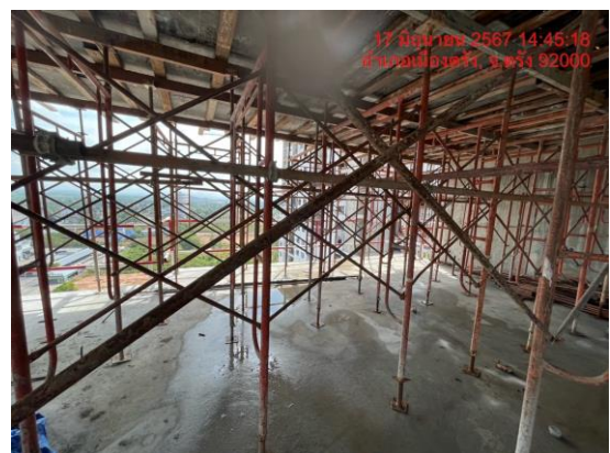
รูปที่ 3.1-69 นั่งร้านที่ได้มาตรฐาน สำหรับการทำงานบนที่สูงเกิน 2 เมตรขึ้นไป
