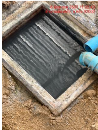
รูปที่ 3.1-46 ป่อตกตะกอนภายในพื้นที่ก่อสร้าง
